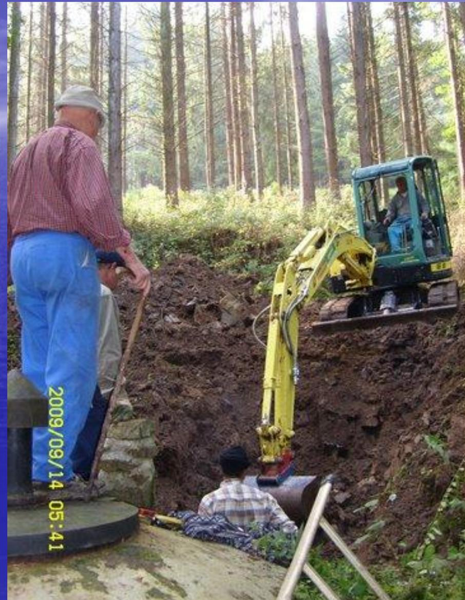
Construction d'un mur de barrage pour une meilleure réception des eaux de sources.
