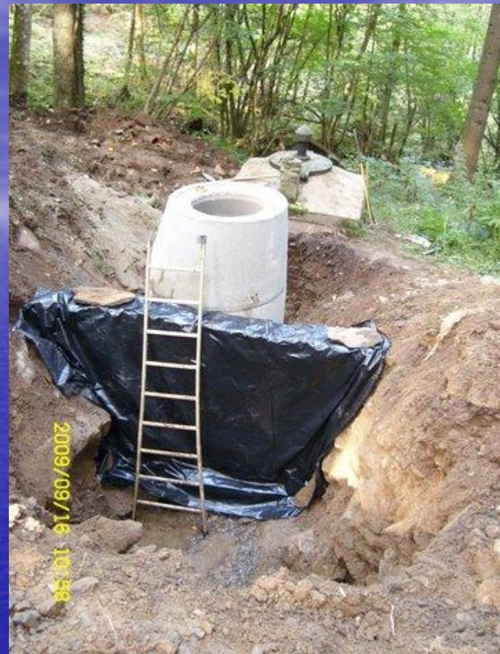
Pose d'un film plastique et de béton au fond de l'ouvrage pour garantir une étanchéité parfaite.
