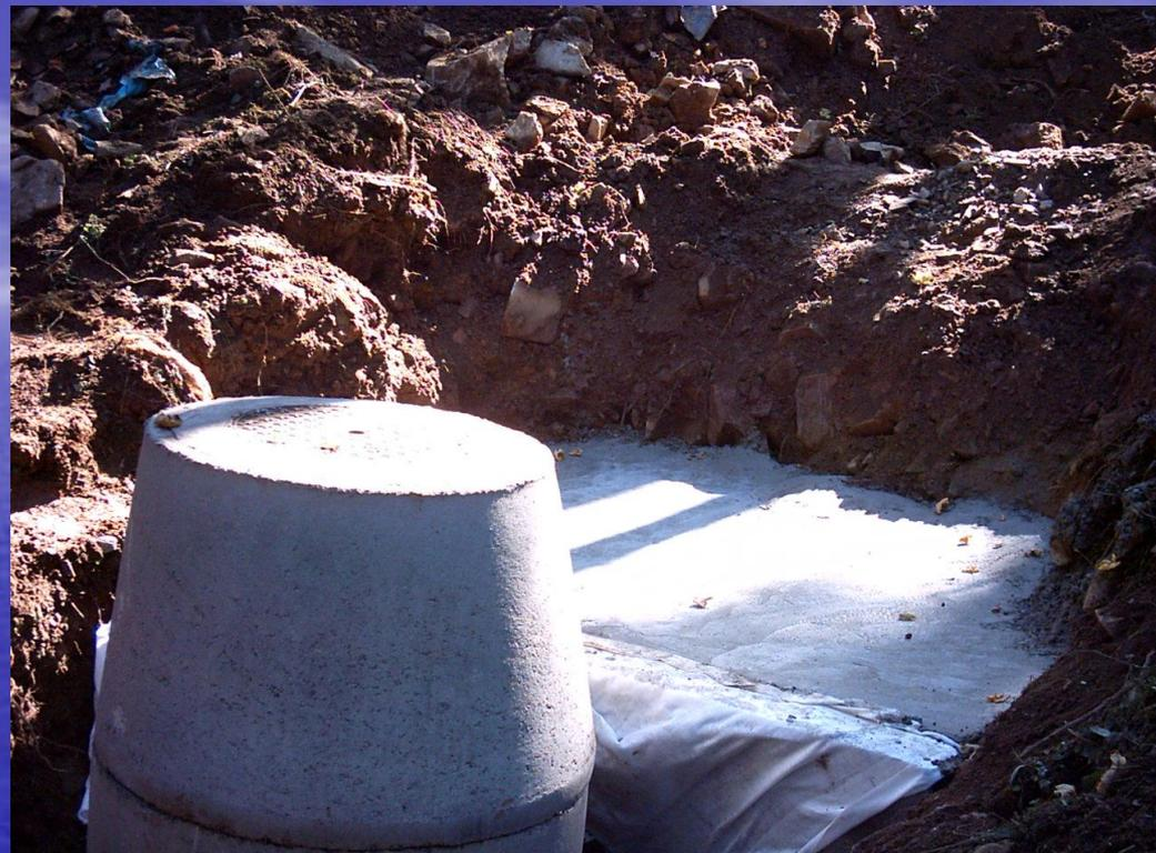
Recouvrement des galets avec du géo-textile, pose d'un film plastique et pour finition une couche de béton avec une légère pente vers l'avant pour éviter l'infiltration d'eau de surface.
