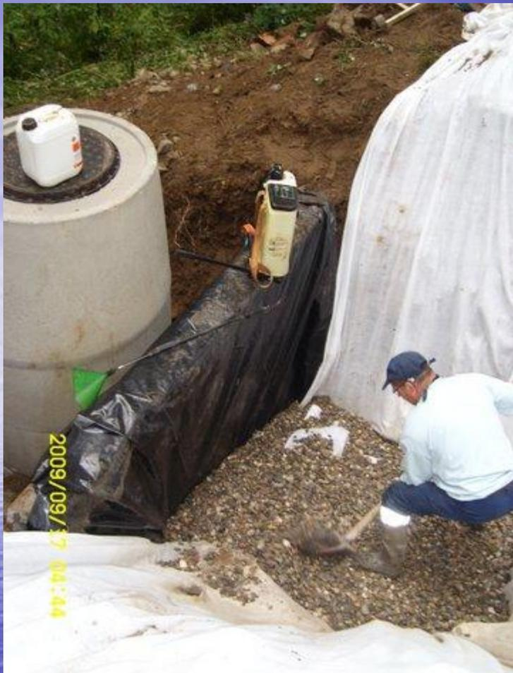
Mise en place du géo-textile et remplissage de l'ouvrage avec des galets désinfectés.
